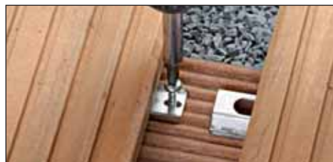
Bild 18, Verschrauben der Abschlussdiele
