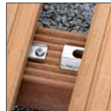
Bild 13/14, Terrassen-DielenClip unter die bereits befestigte Diele auf den verschraubten Clip schieben
