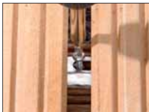
Bild 7, Lösen der Befestigung in der Fuge
