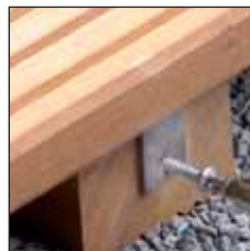
Bild 18, Verschrauben der Abschlussdiele
