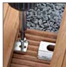
Bild 15, Clip auf Lagerholz verschrauben
