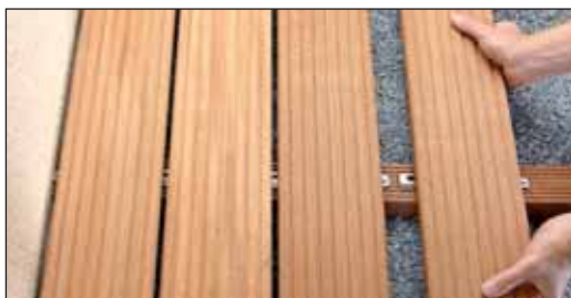
Bild 2, Terrassen-DielenClip wird unter die bereits montierte Diele geschoben. Leichtes Verlegen.
