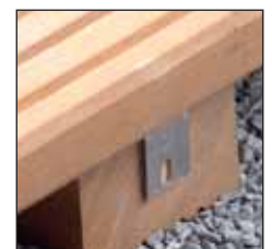
Bild 17, Anfangs-/Enddiele ohne umlaufende Fuge
