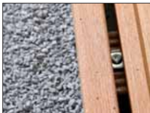
Bild 3, umlaufende Fuge mit Abschlussbrett
