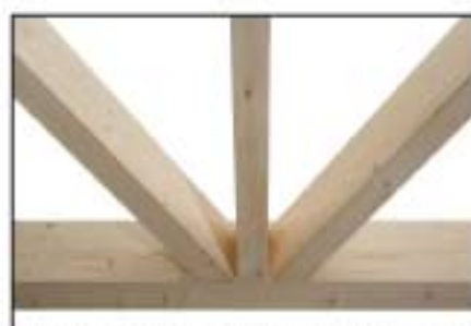
Orthogonaler und horizontal geneigter Anschluss Hauptträger – Nebenträger.
