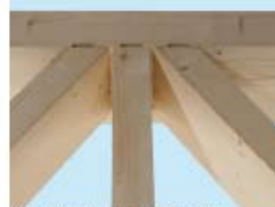
Orthogonale und horizontal geneigter Anschluss Hauptträger – Nebenträger.
