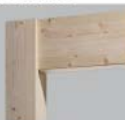
Orthogonaler Anschluss: Stütze-Riegel.
