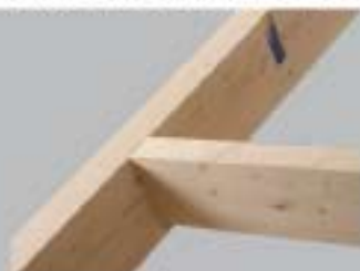
Haupt-Nebenträger Verbindung. Hauptträger ist vertikal geneigt.
