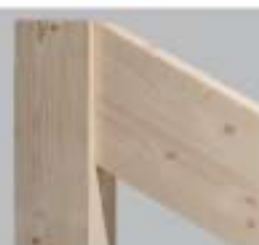
Vertikal nach unten geneigter Anschluss: Stütze-Riegel.
