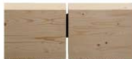
Anschluss einer Gerberpfette mit Schattenfuge
